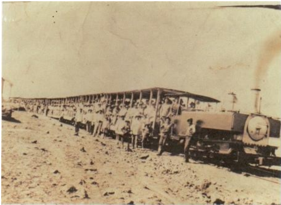
Tren con trabajadores de las clichera
