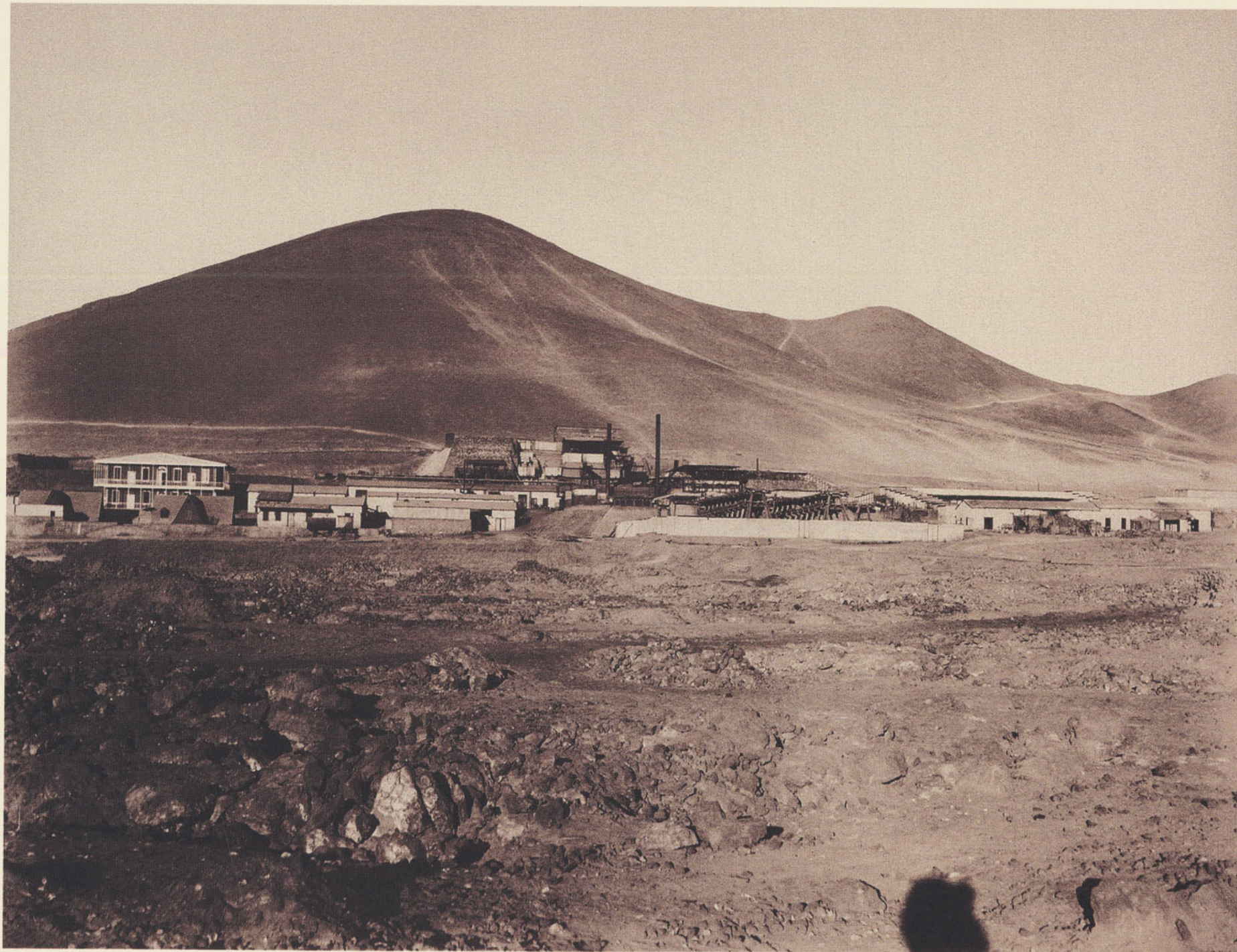
Oficina San Juan VISTA JENERAL
