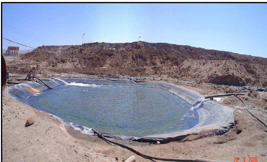
Piscina de acumulación (ilegal) de agua. Instalaciones de Cosayach (Compañía de Salitre y Yodo de Chile). Fotografía tomada durante inspección de la DGA, hecho que derivó al actual ejercicio del Consejo de Defensa del Estado por uso irregular de un bien nacional.
