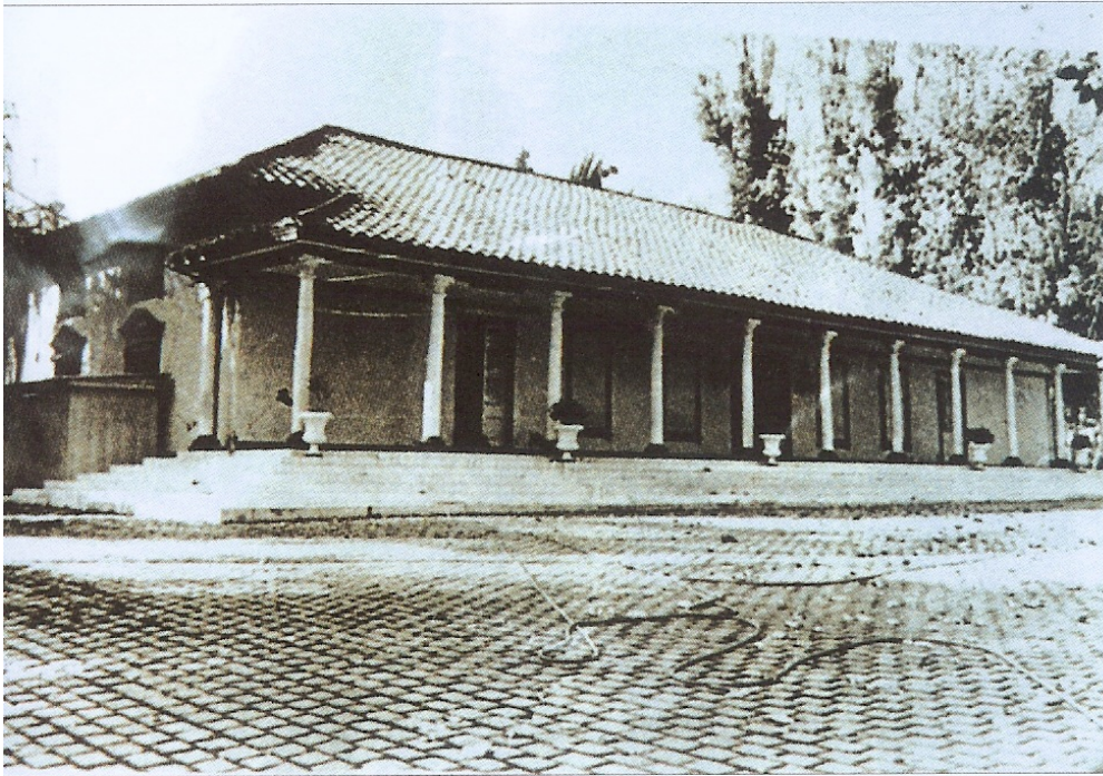
Centro de Tortura Villa Grimaldi 520 (José Arrieta 8200, Santiago). Fuente: Informe Valech, p. 465.
